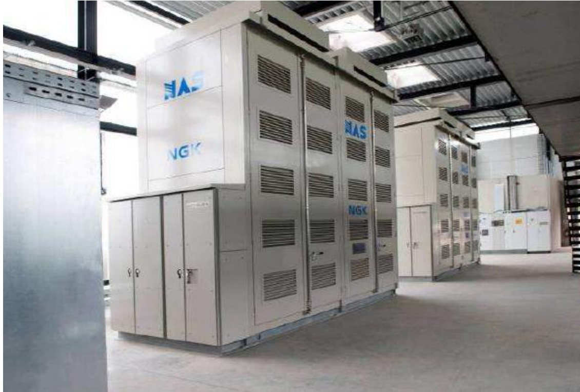
2 x 0.5MW/3.6MWh NaS Batterie (Yunicos)
